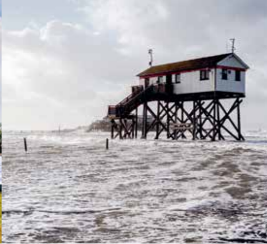
Pfahlbauten auf dem überfluteten Strand
